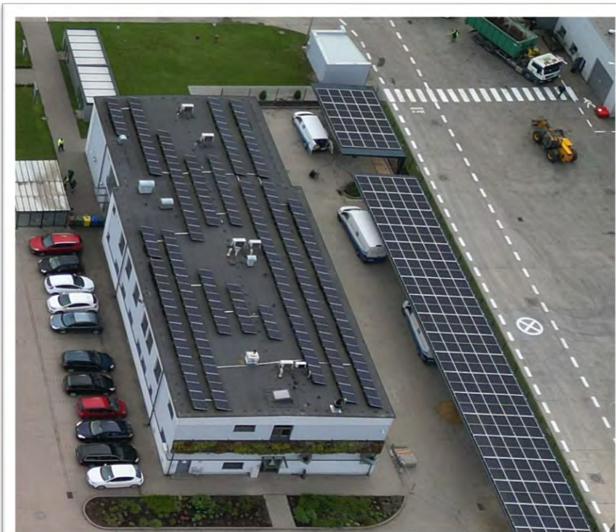
WIATA SOLARNA ZE STACJĄ ŁADOWANIA SAMOCHODÓW ELEKTRYCZNYCH
