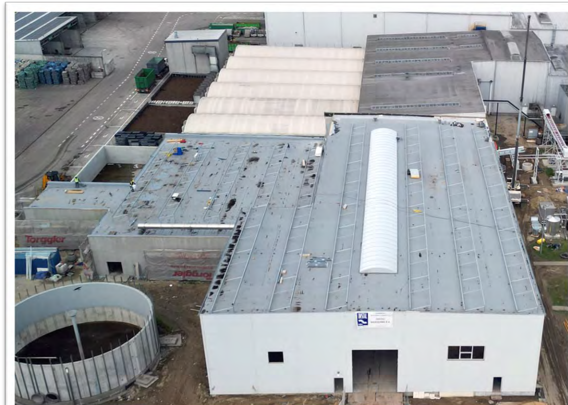
POŁĄCIE DACHOWE NA NOWYCH BUDYNKACH WCR
