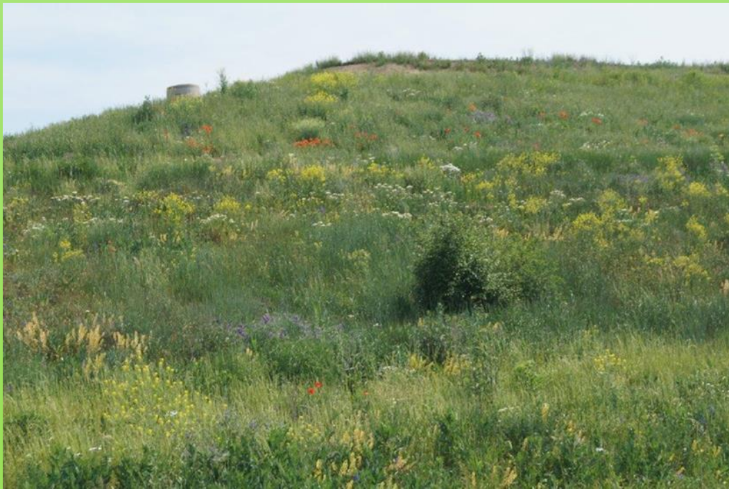
Kwatera składowiska po rekultywacji
