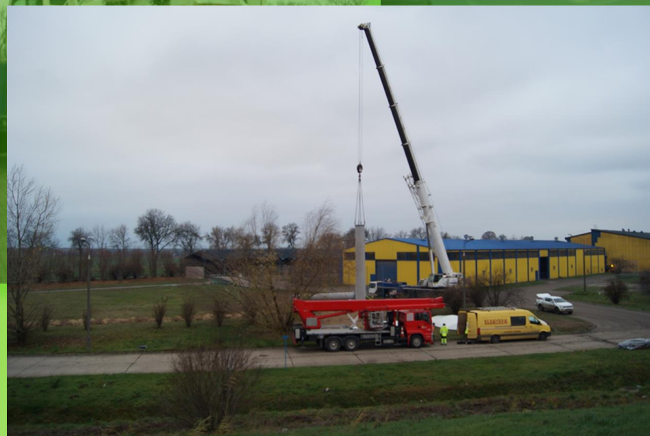
Montaż turbiny wiatrowej - maszt o wysokości 24 m
