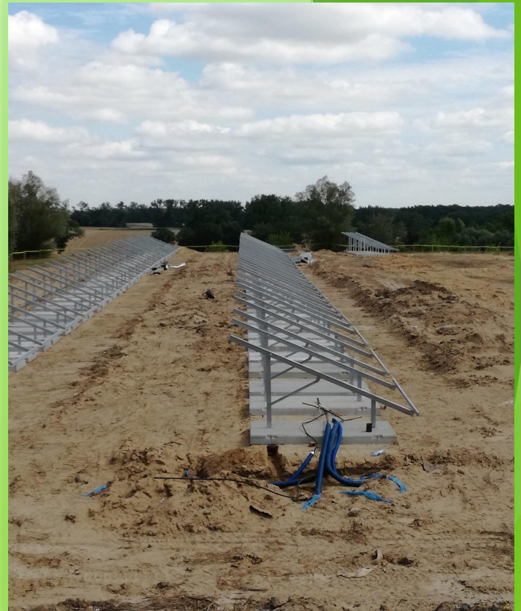
Etapy budowy farmy fotowoltaicznej (konstrukcje betonowe i stalowe)
