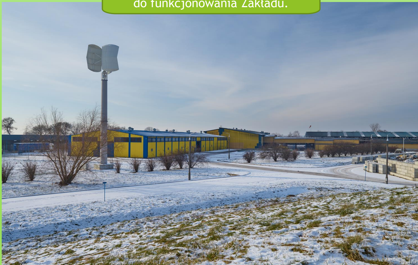
Zakład przetwarzania odpadów - widok ze zbocza kwatery
