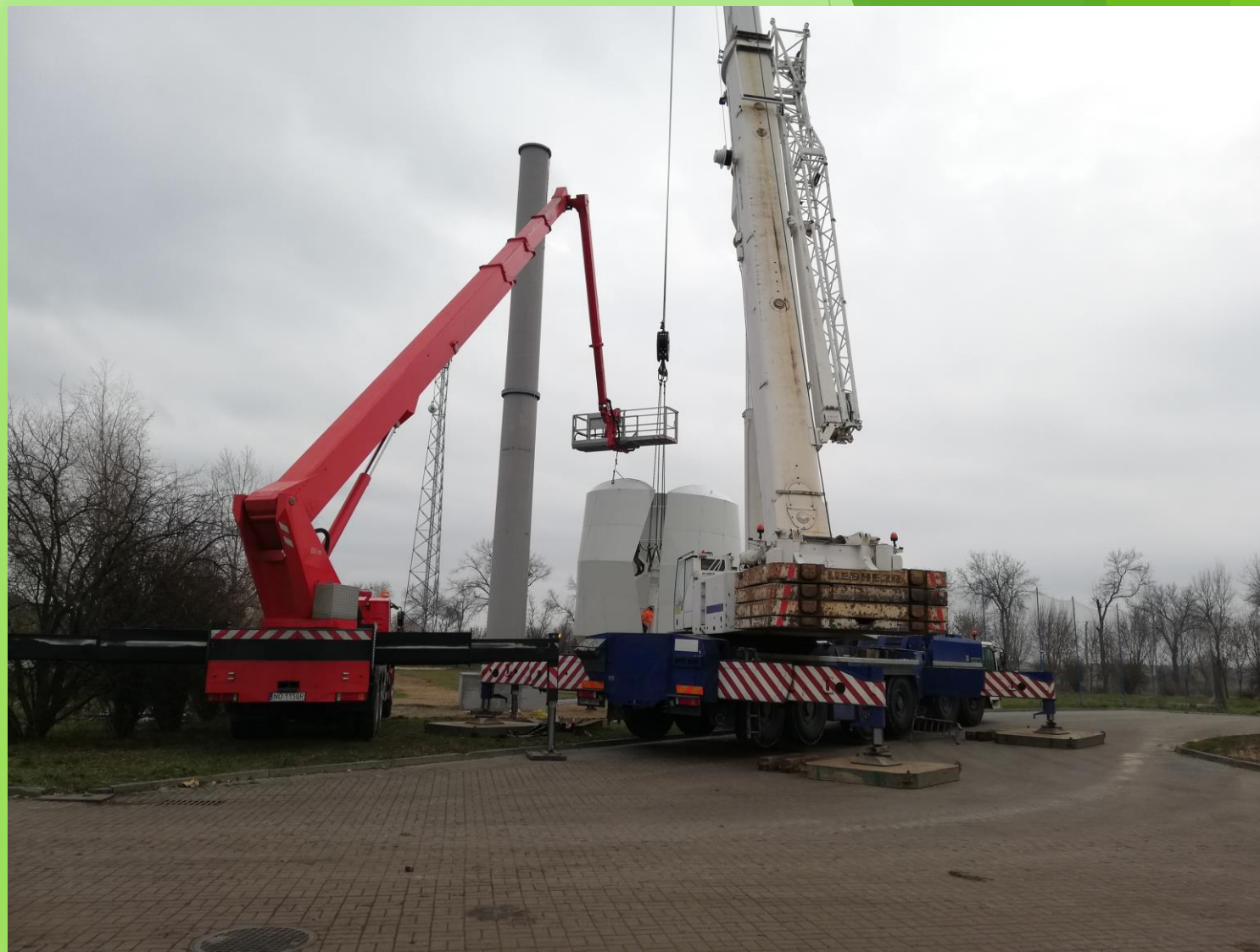
Montaż śmigła turbiny wiatrowej
