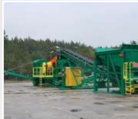
Zakład przerobu odpadów budowlanych 25 000 Mg/rok
