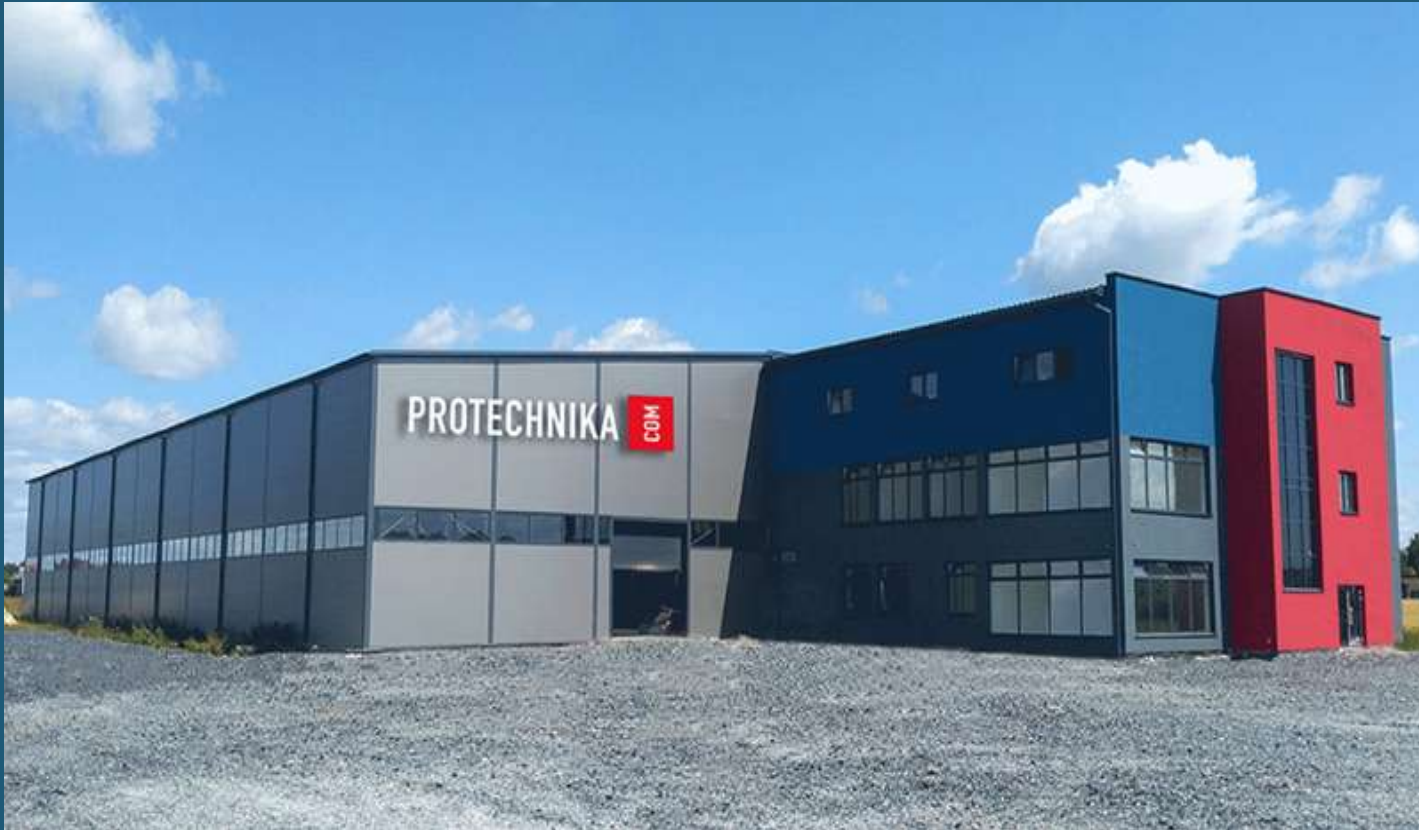
Zakład produkcyjny Protechniki w Dębowicy (Łuków)
